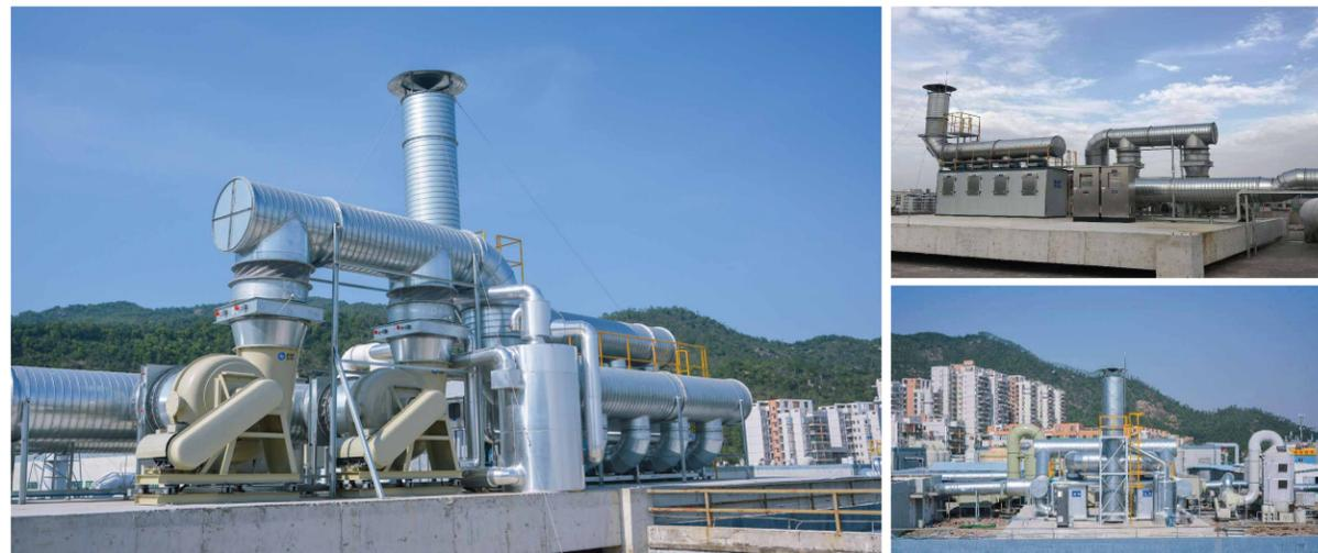
废气末端处理装置
